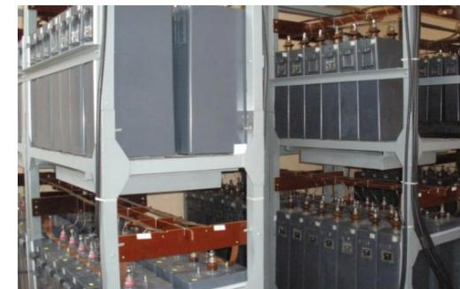
*Конденсаторная батарея установки
